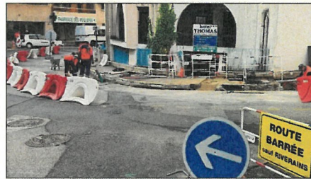
Sur la photo du haut, un enrobé flambant neuf Boulevard du Campon. En dessous, des déviations route de Valbonne. Et, à droite, de larges trottoirs sont en cours de création au début de la route de Valbonne.
