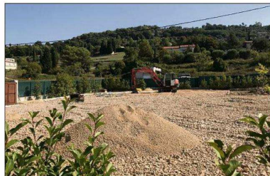
Des tonnes de ballast ont été apportées et étalées ces derniers jours. Pour quoi faire ? Mystère.
